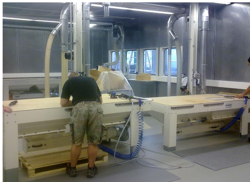
Zwei Expert Z 20 Schleifstaubabsaugtische in der Lackiervorbereitung
