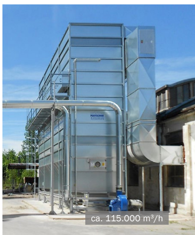
MultiStar Spülluftfilter • Möbelzulieferer
