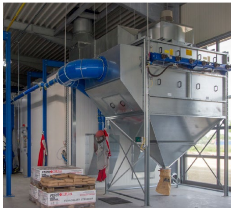
Patronen Jetfilter für Strahlkabinen
