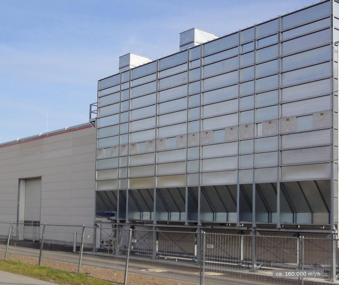
MultiStar Spülluftfilter mit Einblasleerelementen • Möbelfertigung
