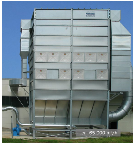
MultiStar Schleusenfilter mit Überbläsung • Möbelzulieferer
