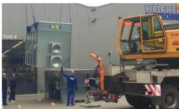
Der Kran im Einsatz.
