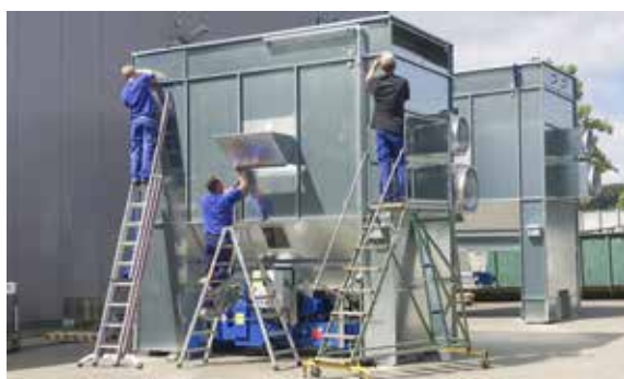
Löschleitung, Flammenableitblech, Abreinigungssteuerung montieren und Motoren anschließen. Fertig.
