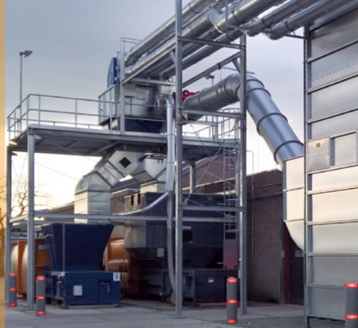
PMA-U Materialabscheider in der Faltschachtelherstellung.
