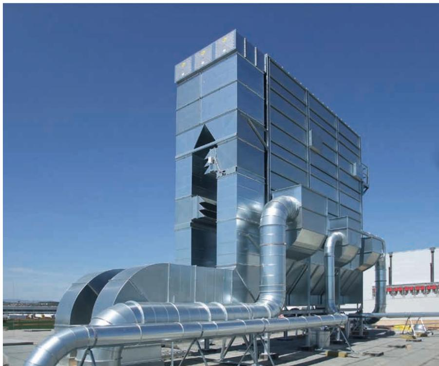
▲ Multistar-Filteranlage für die kontinuierliche Arbeit im Unterdruckbetrieb: Die Abreinigung erfolgt über Niederdruck-Spülluftventilatoren, die Filterentleerung über eine Förderschnecke
